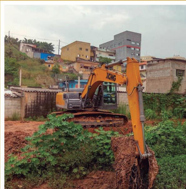
A Prefeitura, por meio da Secretaria de Obras, está desenvolvendo um importante projeto de desassoreamento no córrego dos Macacos, situado no Parque da Mina do Ouro. Com o propósito de aprimorar a capacidade de escoamento da água durante períodos chuvosos, a ação abrange um abrangente processo de limpeza e alargamento do leito do córrego.
